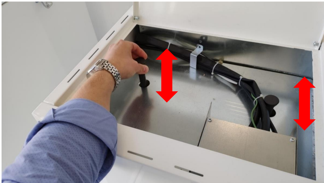
Czyszczenie zawirówywaszy spalin
