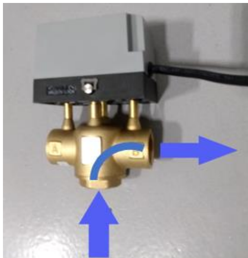
Przepływ do CO (kierunek na zaworze: AB-B)
