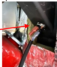
Czujnika detekcji cofnięcia się płomienia 105 °C.
