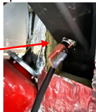
Czujnika detekcji cofnięcia się płomienia 105 °C.
