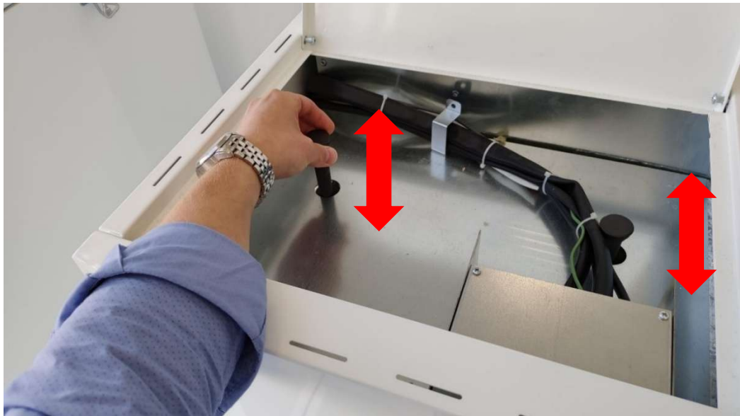
Czyszczenie zawirówyaczy spalin
