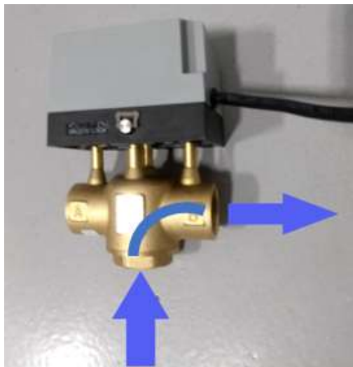
Przepływ do CO (kierunek na zaworze: AB-B)
