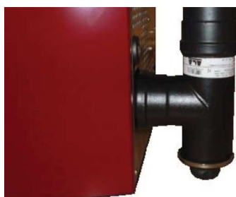
Fig. 75 - Fume conduit cleaning
